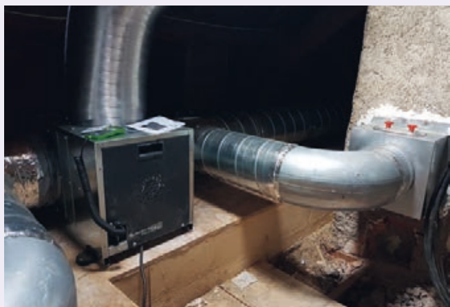
PLM_PS en comble
